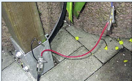
Bild 55: Provisorische Einspeisung der Vertikalantenne von DC1DV; an der Einschlaghülse laufen auch alle Radials zusammen.
